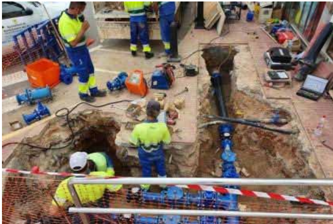
Operarios de Aqualia trabajando en una avería. | R.I. - Archivo
