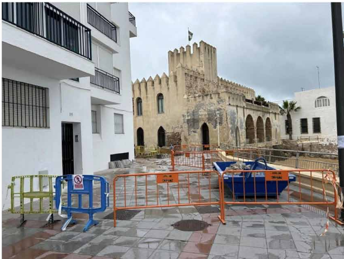
Dan comienzo las obras de reparación del muro junto al Castillo de Chipiona tras los daños producidos por los temporales.
