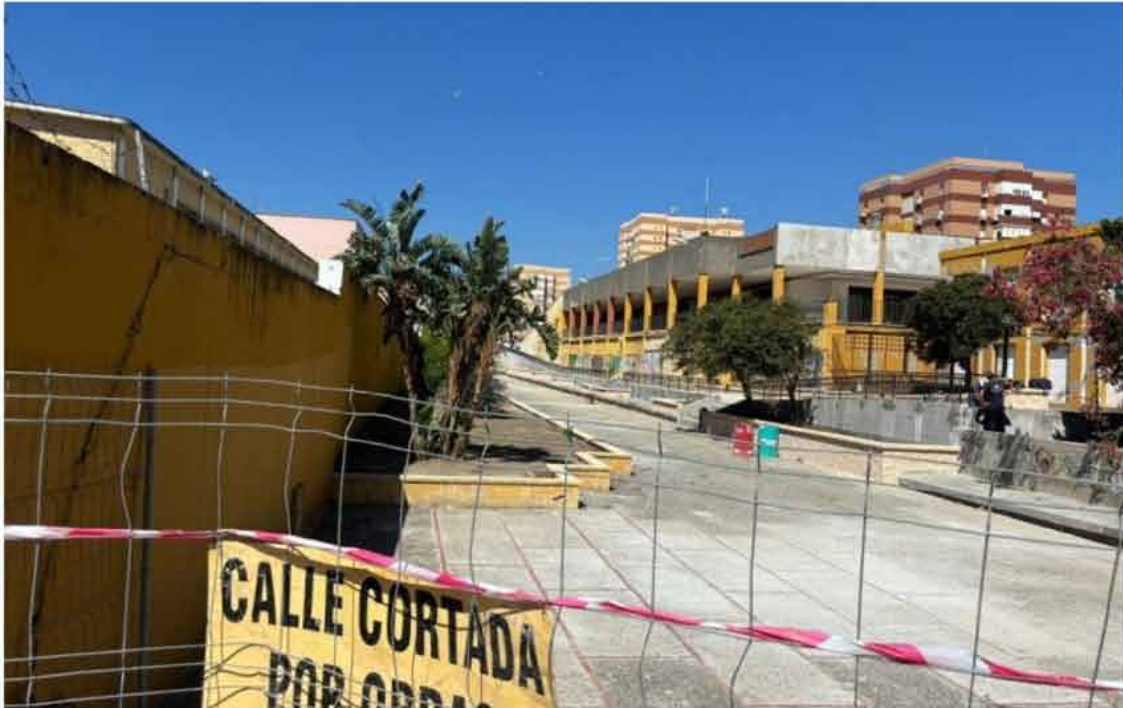
Así se encuentra el antiguo magallanes tras las obras. / Á.C.G.
